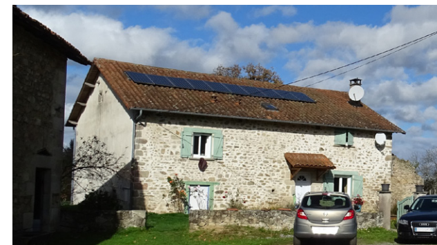
Exemple de panneaux solaire en toiture plutôt bien intégrés : couleur sombre du cadre et des panneaux, pose régulière. Menuiseries homogènes sur l'ensemble de la façade
