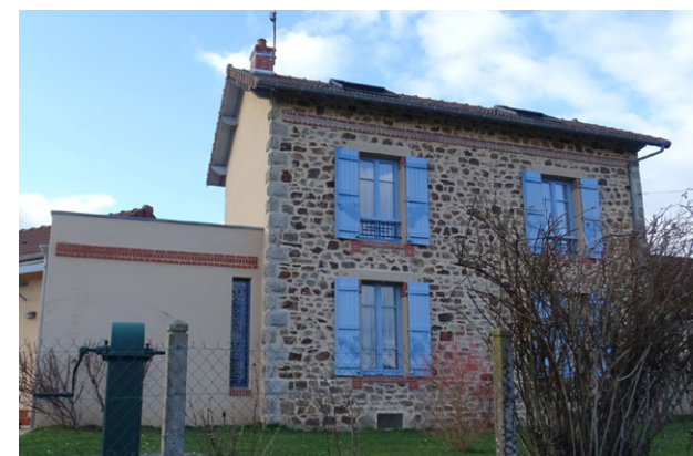
Exemple d'extension en harmonie avec le bâti ancien : proportions, enduit de la couleur des joints, rappel du dessin en brique
