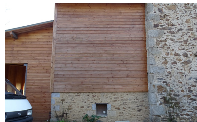
Exemple de bardage bois pouvant accompagner une isolation du bâti ancien par l'extérieur (l'isolant devant toutefois permettre les échanges hygrométriques pour une bonne tenue de la construction)
