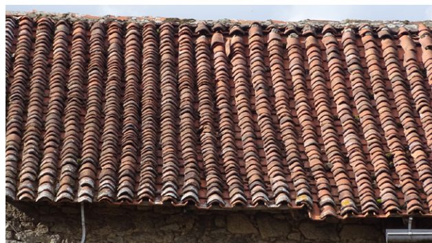
Toiture en tuile canal
