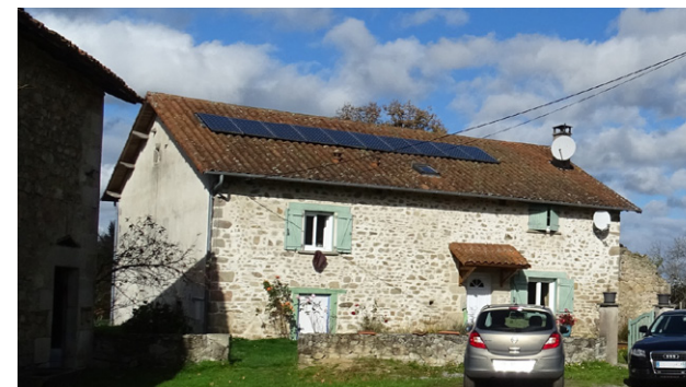
Exemple de panneaux solaire en toiture plutôt bien intégrés : couleur sombre du cadre et des panneaux, pose régulière
