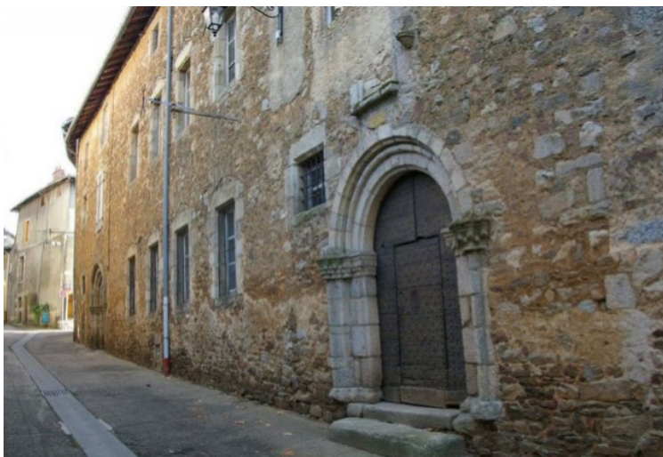
L'hôpital médiéval et sa porte d'entrée
